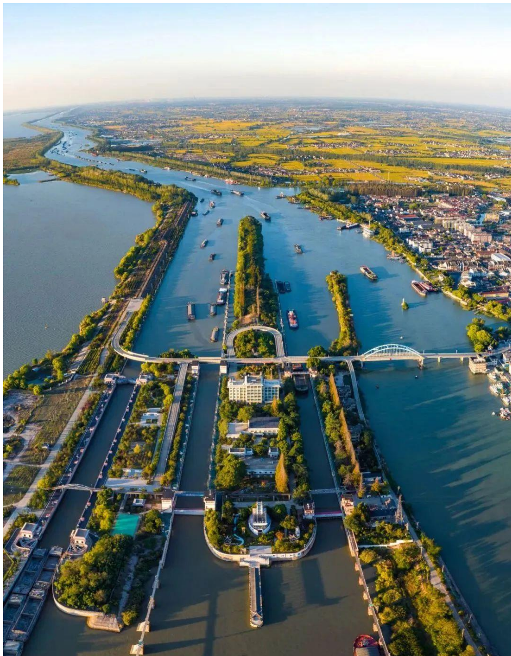
© 京杭大运河扬州段上的邵伯船闸
